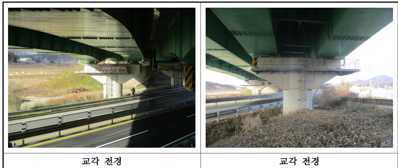
【사진 3.11】 교각 전경
