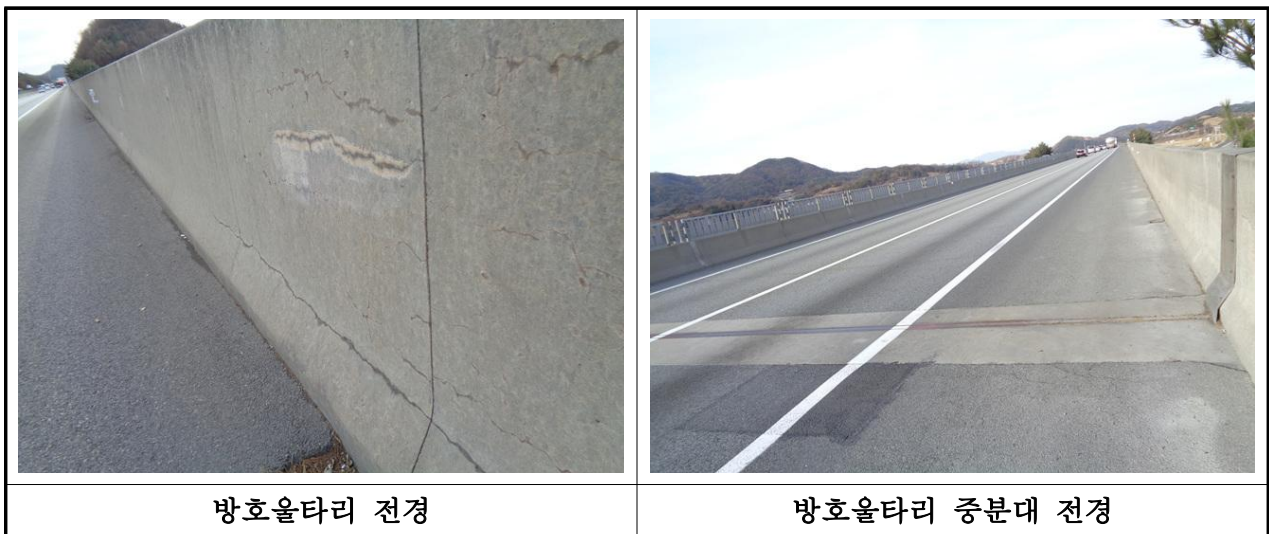
【사진 3.24】 난간 및 연석 전경
