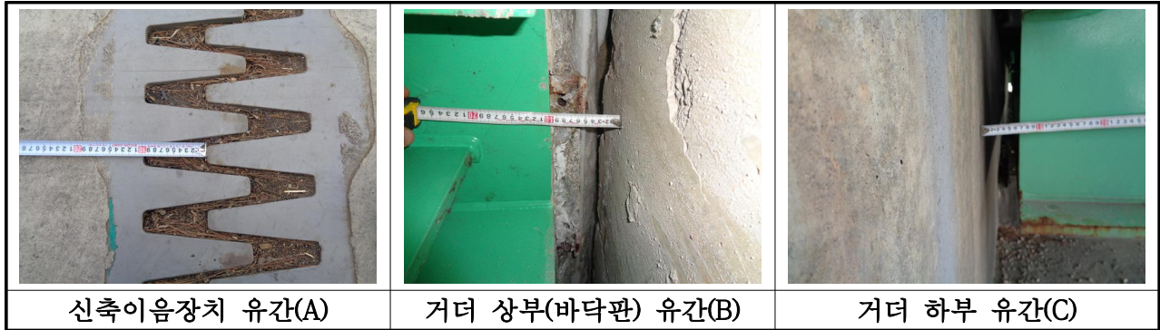
【사진 3.42】 신축이음 유간 측정방법
