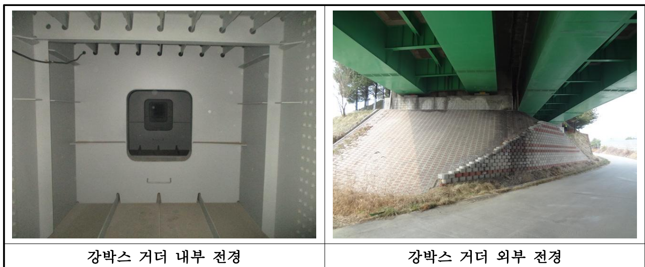
【사진 3.4】 강박스 거더 전경
