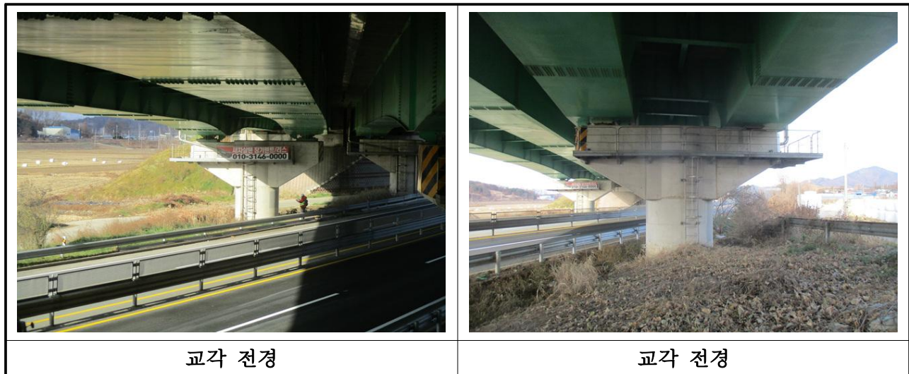
【사진 3.35】 교각 전경
