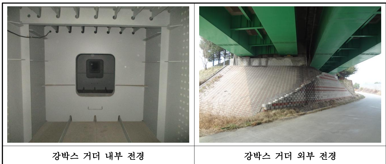
【사진 3.28】 강박스 거더 전경
