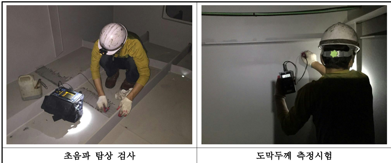
【사진 3.50】 강재 내구성조사 전경
