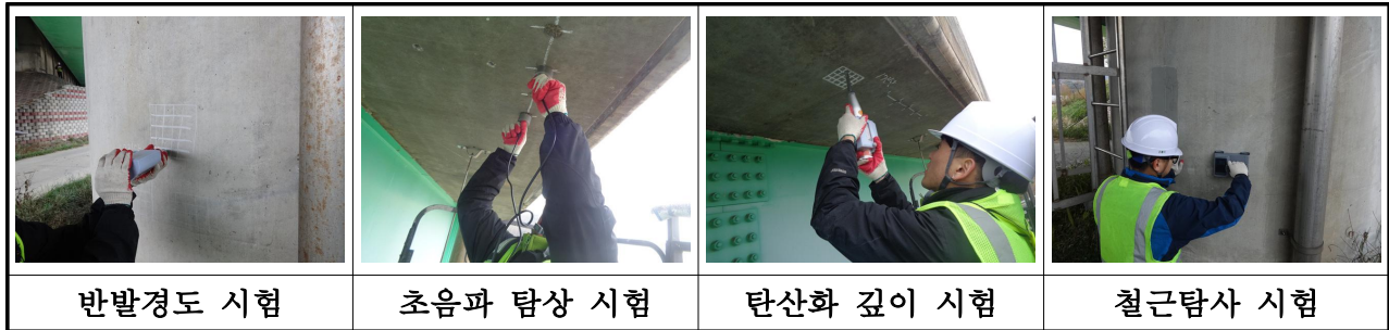
【사진 3.49】 콘크리트 내구성조사 전경
