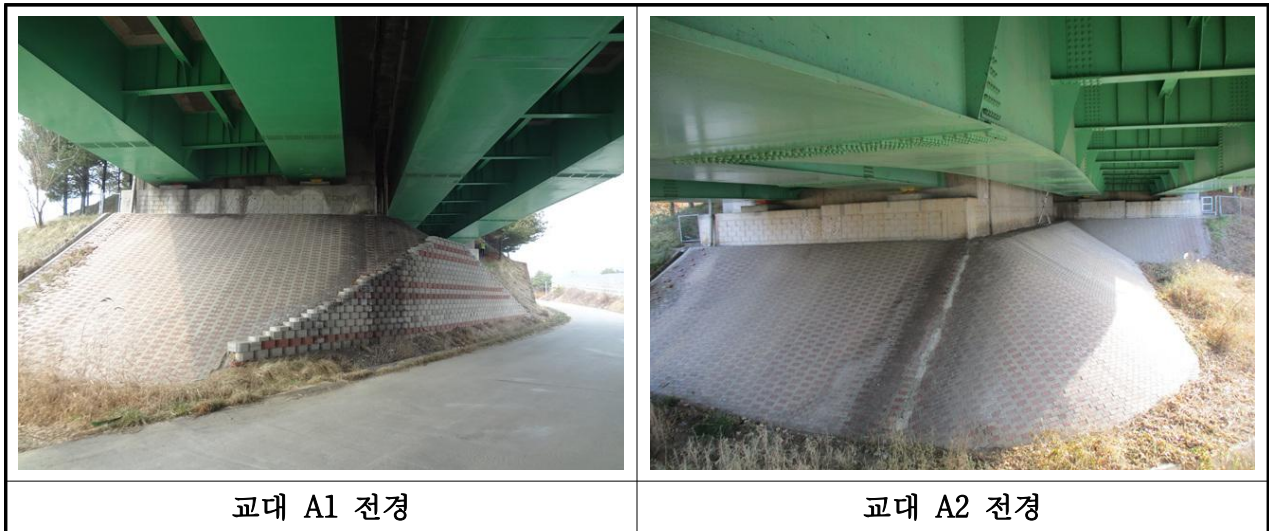
【사진 3.33】 교대 전경
